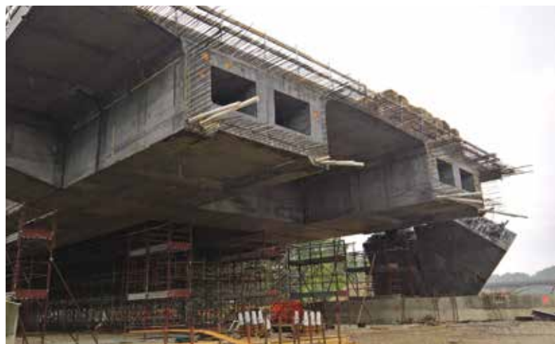
10. La sezione terminale del viadotto d'approccio lato Vigevano
