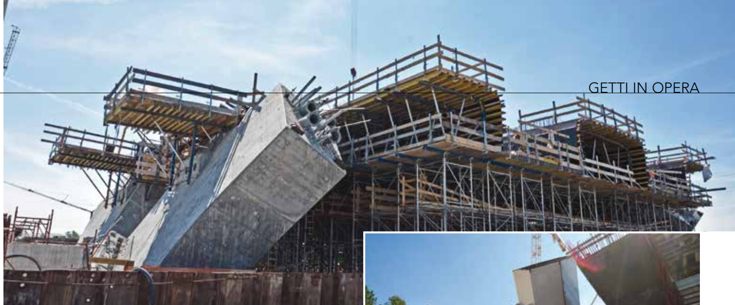
5. La testa-pila centrale
