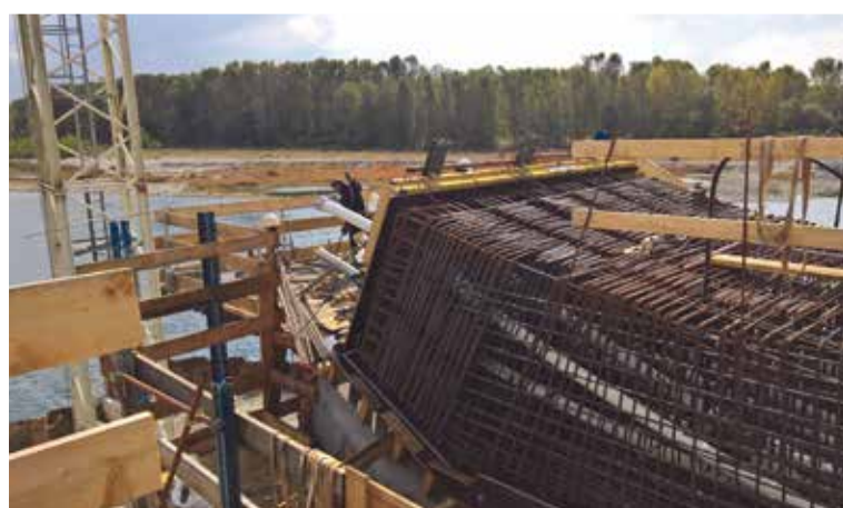
8. L'armatura del traverso testa-pila
