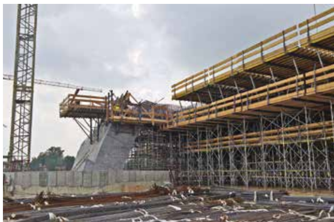
6. La casseratura della campata del viadotto d'approccio
