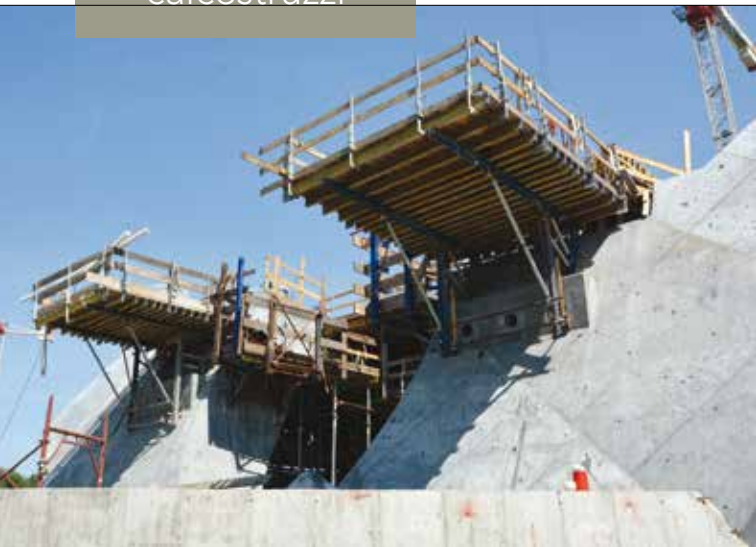
9. Le piattaforme di lavoro per la tesatura dei traversi testa-pila
